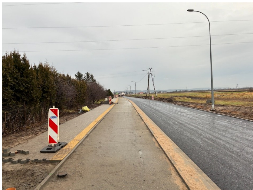
Zdjęcie nr 8 - Budowa ul. Rolniczej
