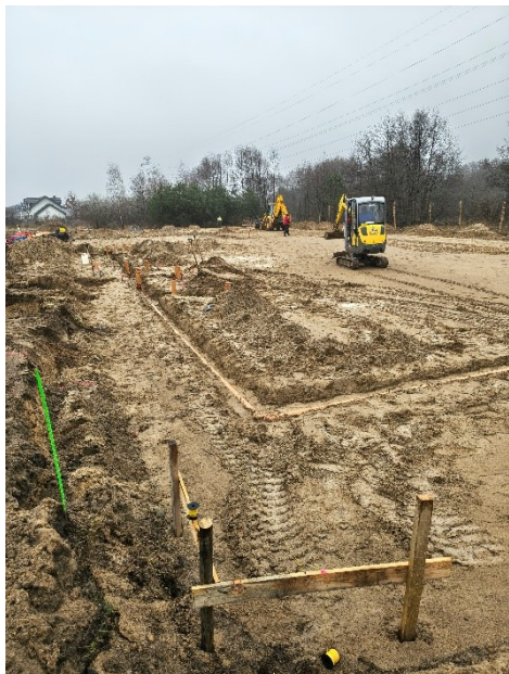
Zdjęcie nr 4 - Początek budowy filii SP 3
