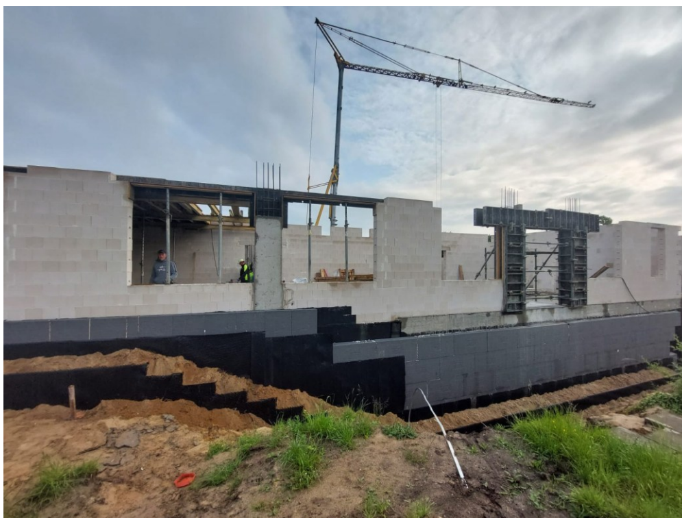
Zdjęcie nr 3 - Budowa żłobka przy ul. Gniewowskiej
