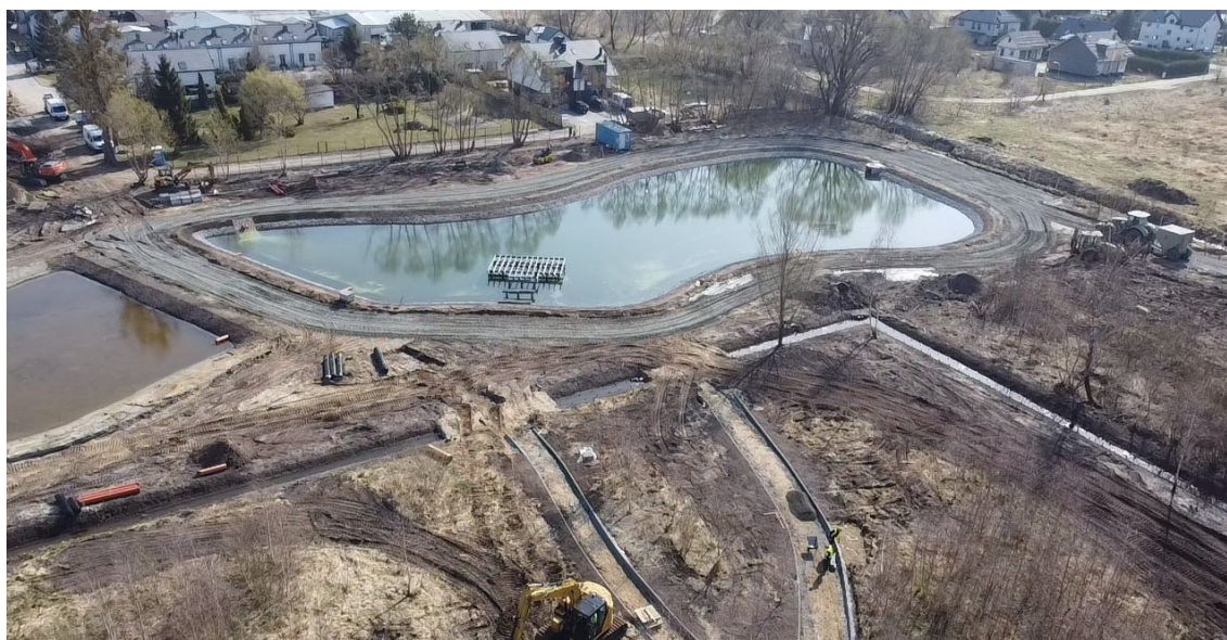
Zdjęcie nr 3 - Zbiornik retencyjny w budowie
