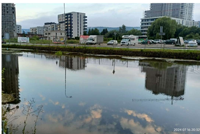
Fot. 2. Zbiornik retencyjny w rejonie ul. Morskiej i Marynarskiej (należący do dewelopera, który zbudował osiedle w sąsiedztwie tych ulic) przed i po ulewie 16.07.2024
