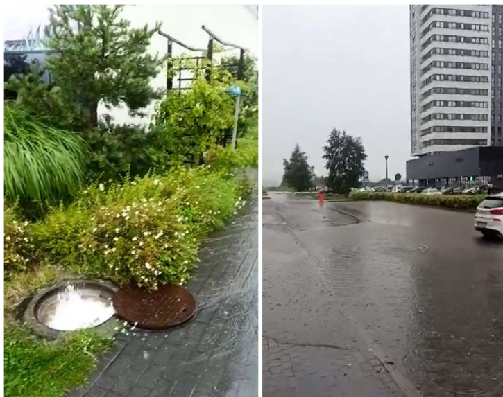
Fot. 1. Niewydolny system kanalizacyjny w rejonie ul. Morskiej w trakcie ulewy 16.07.2024
